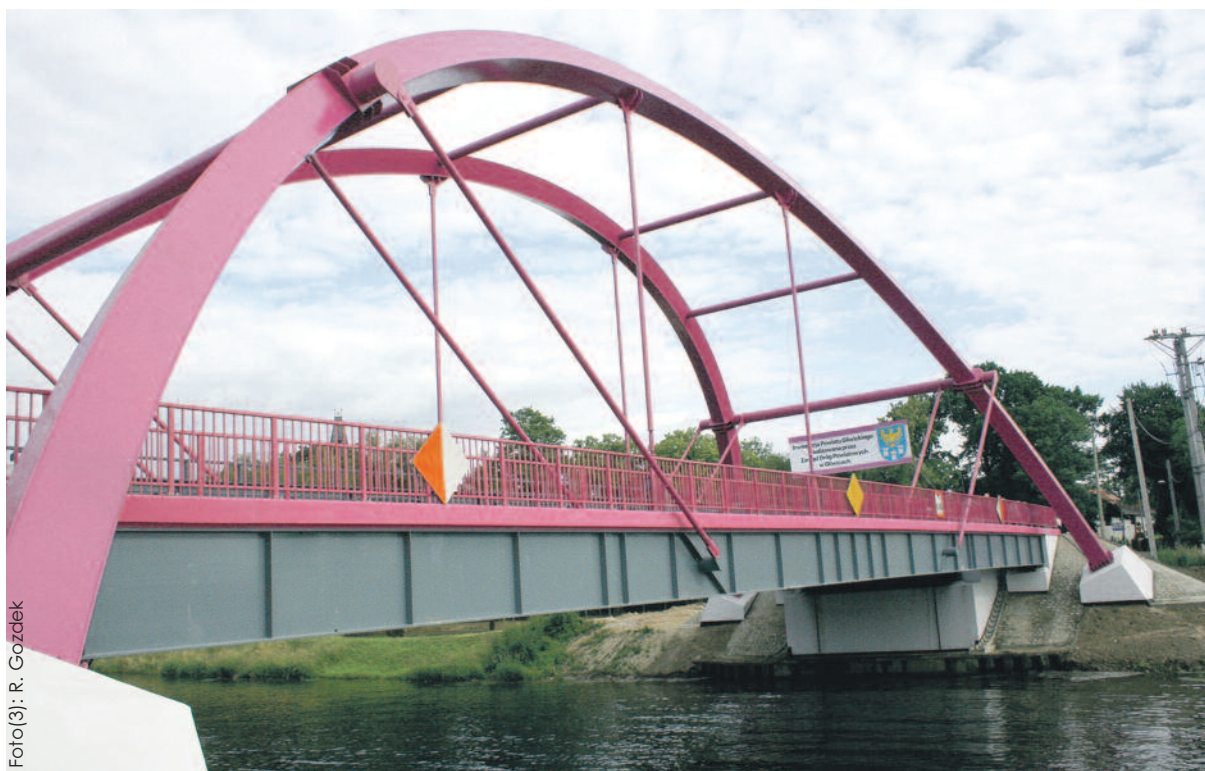
Nowy most nad Kanalem Gliwickim w Pławniowicach jest nie tylko funkcjonalny, ale też przyciąga wzrok swą konstrukcją.
