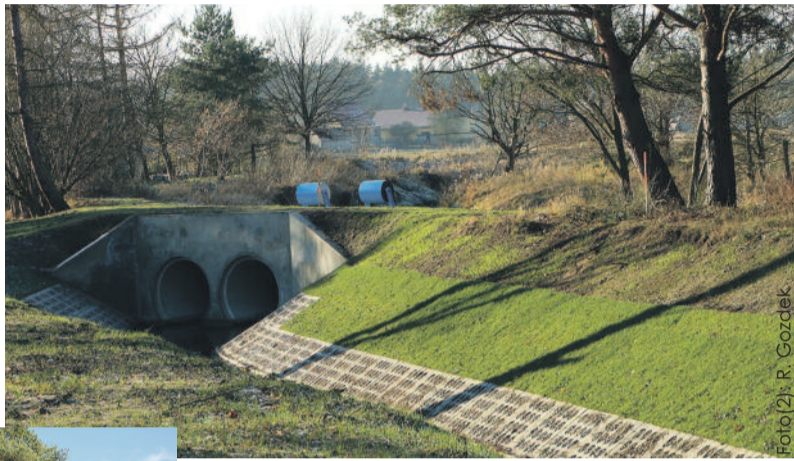
Rów doprowadzający wody do Bierawki został należycie zabezpieczony na wypadek powodzi.
