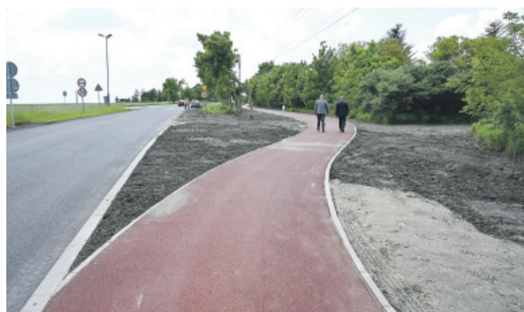
Fragment przebudowanej ul. Powstańców Śląskich w Pyskowicach wraz ze ścieżką rowerową.
