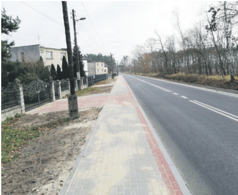
Rzeczyce: zjazd przebudowany przez zarządcę drogi podczas realizacji przez niego zadania inwestycyjnego polegającego na przebudowie drogi i przebudowie chodnika.
