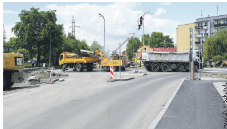
Prace na rondzie łączącym ul. Szpitalną z ul. Kosmonautów w Knurowie.
