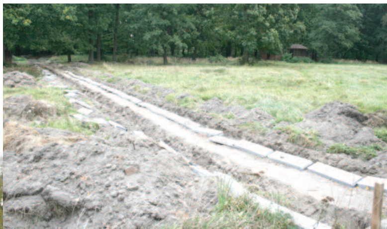
Tak park wyglądał we wrześniu ub. roku, podczas prowadzonych prac ziemnych.
