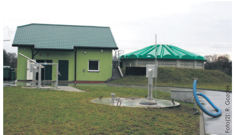
Nowoczesna oczyszczalnia ścieków w Sierakowicach.
