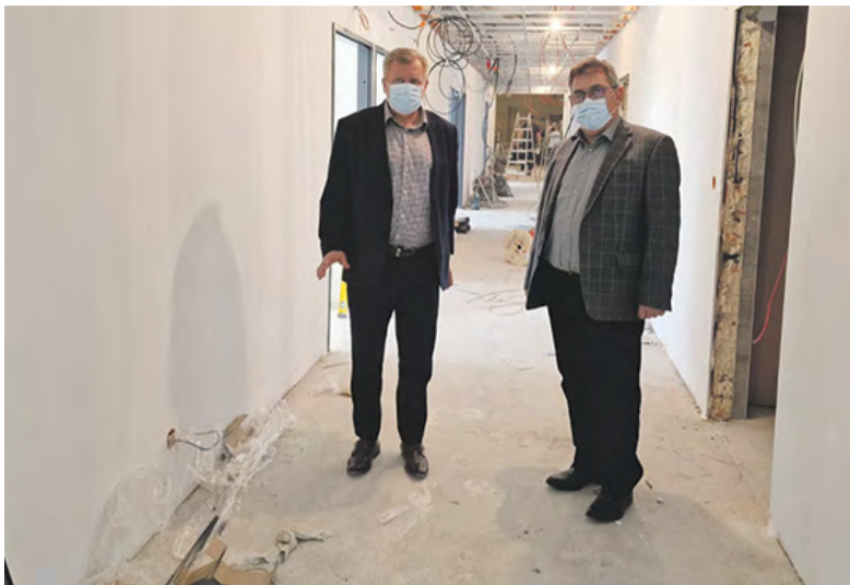
Waldemar Dombek, starosta gliwicki oraz Leszek Kubiak, prezes Zarządu Szpitala w Pyskowicach Sp. z o.o. oglądają postępy prac budowlanych. Foto: archiwum.
