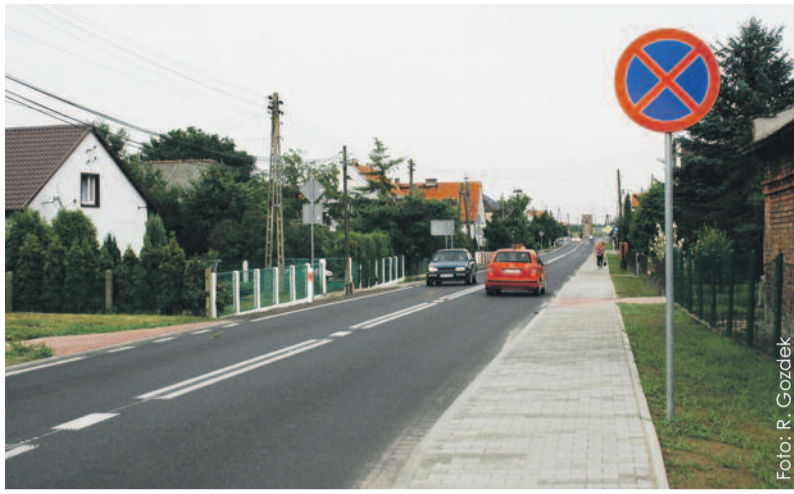
Droga powiatowa w Kleszczowie zmieniła się nie do poznania – ma nową nawierzchnię, zjazdy, oznakowanie, chodniki, odwodnienie...
