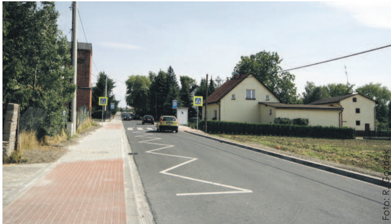
Fragment przebudowanej ulicy Dolna Wieś w Pilchowicach.
