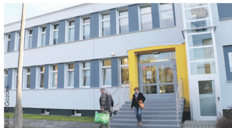
Przychodnia Nr 2 przy ul. Kazimierza Wielkiego 6 w Knurowie.
