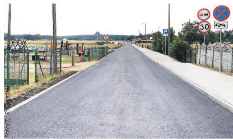
Przebudowana droga jest szersza niż dotychczasowa, ma też wygodny chodnik dla pieszych.
