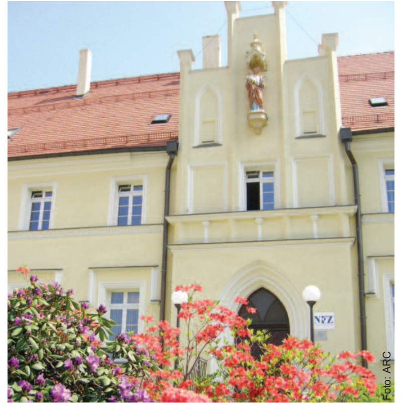
Od początku istnienia szpitala w Pilchowicach na froncie budynku widnieje figura jego patrona, św. Józefa.
