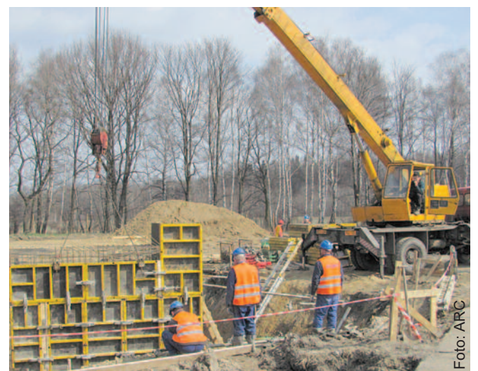
Gmina Gierałtowie w wielu miejscach zamieniła się w wielkie pole budowy.
