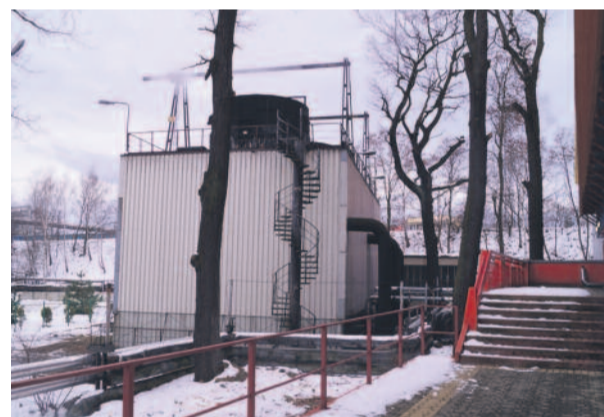
Chłodnia wentylowa pobliskiej kopalni oddaje marnowaną do tej pory energię...
