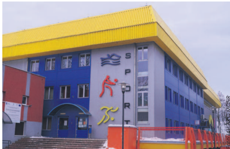
Kryty basen knurowskiego MOSiR-u w Szczygłowicach zyskał nowoczesne ogrzewanie, oszczędzające środowisko.
